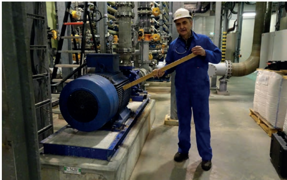
Afbeelding 3: De bump test: een houten balk volstaat. (Foto: Oveducon)
